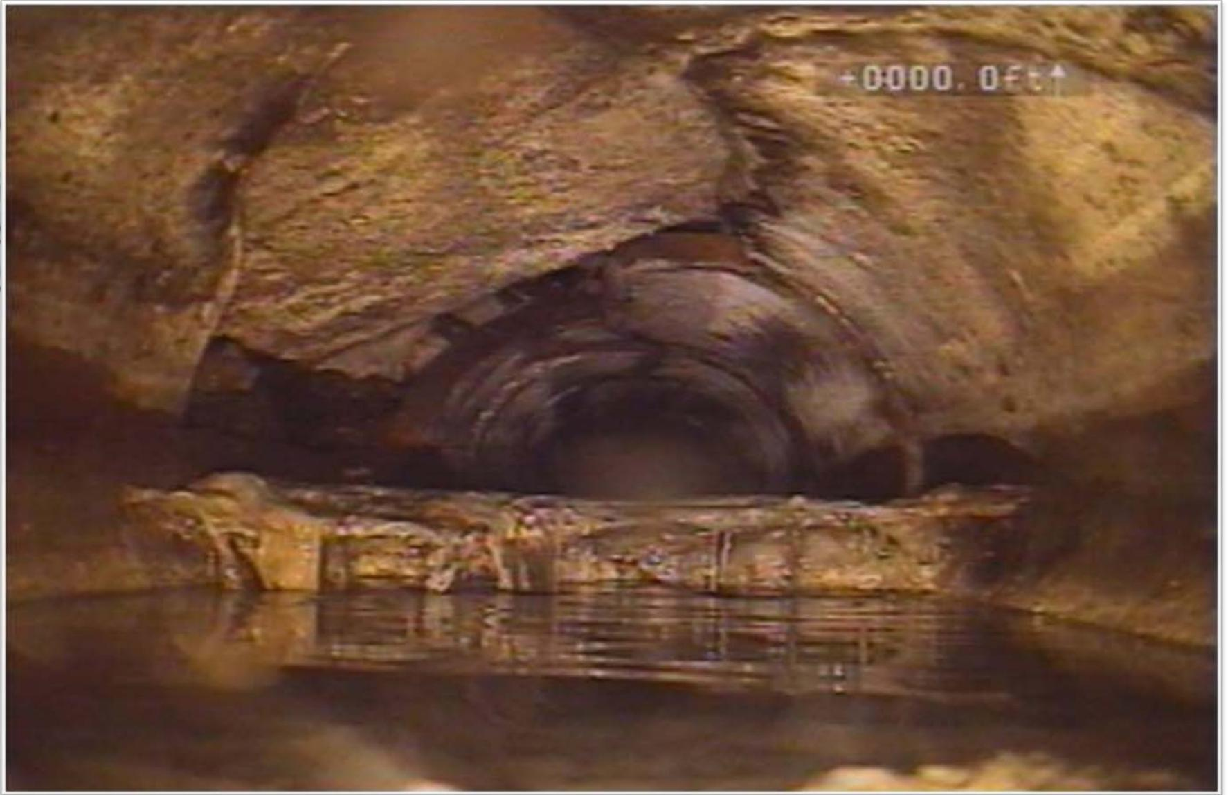
**Colapso de la parte superior de la tubería del colector Montevideo, Colonia Lindavista, Deleg. Gustavo A. Madero.**
